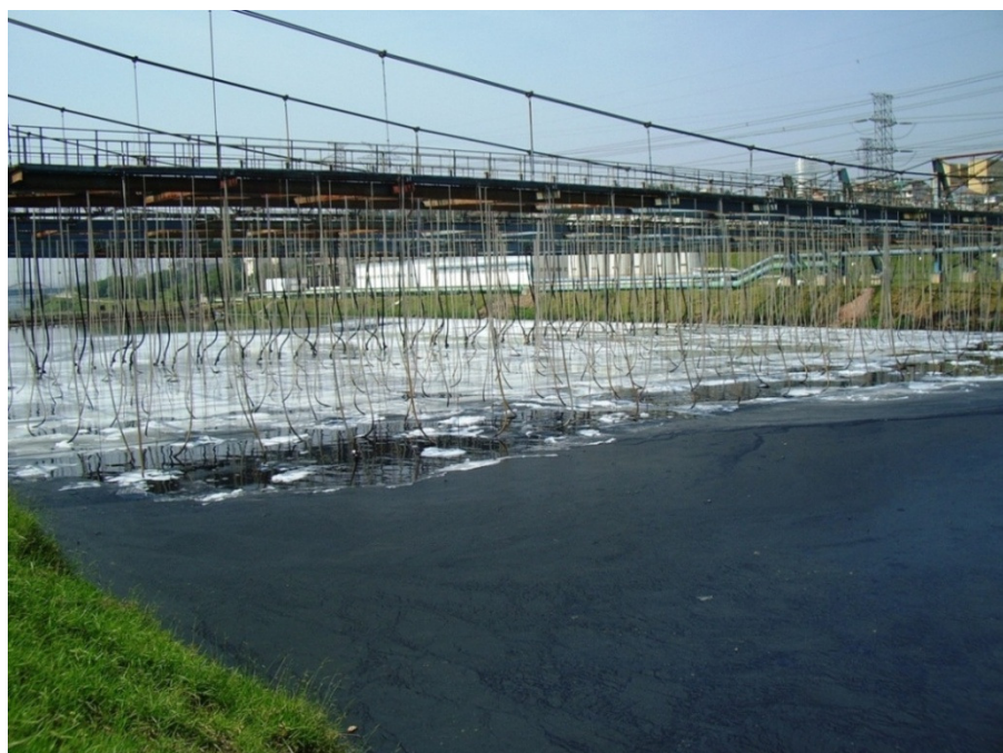
Figura 1.5 – Injeção de ar dissolvido e flotação
