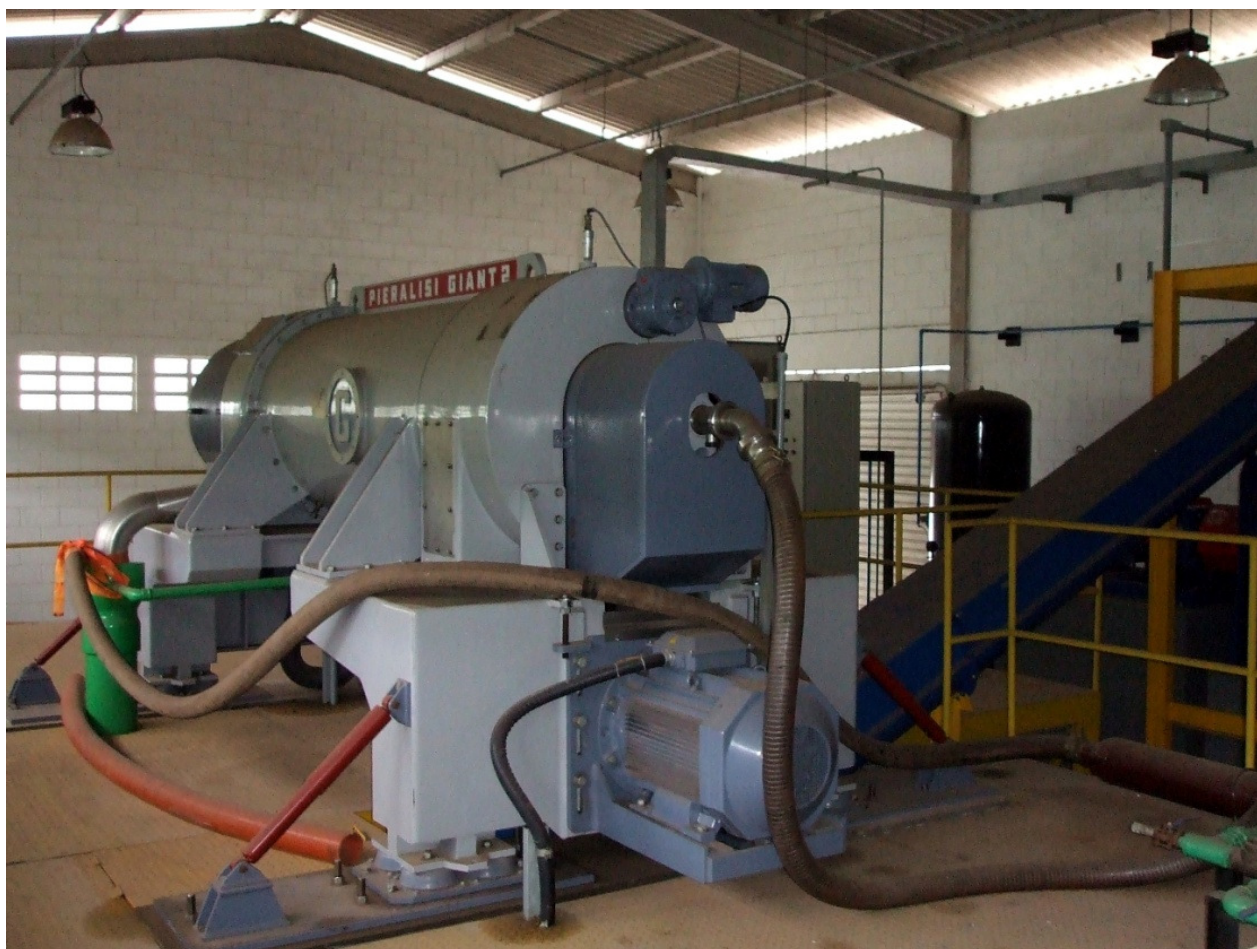
Figura 1.8 – Equipamento para desidratação do lodo
