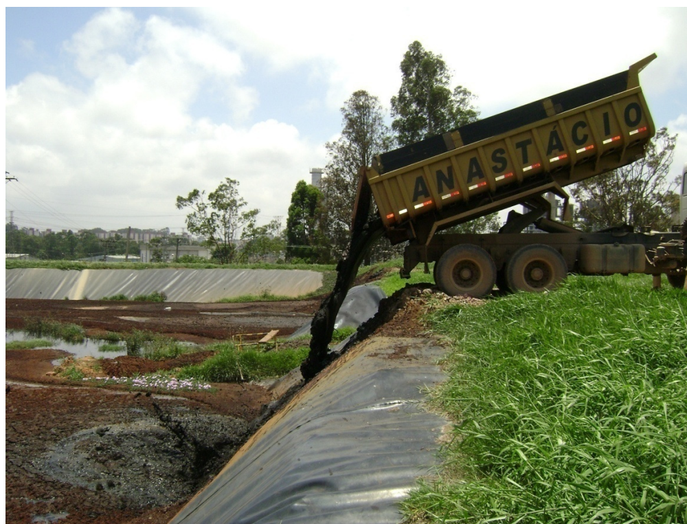
Figura 1.10 – Lançamento do lodo no bota fora
