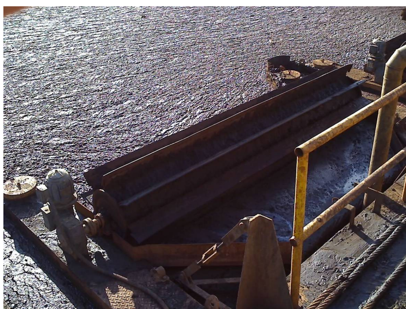
Figura 1.6 – Pás recolhedoras de lodo a jusante da estação para remoção de sólidos flotados
